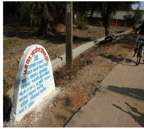
गंदे पानी की निकासी के लिये नाली निर्माण
