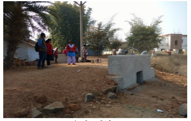
पंचायत में पुलिया निर्माण का काम
