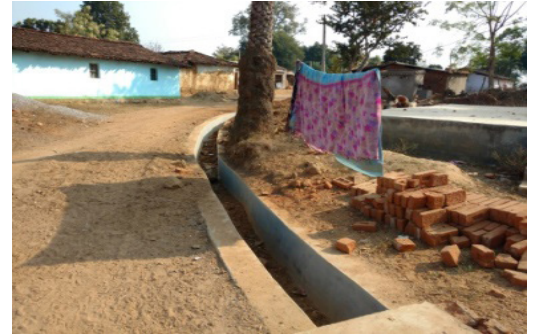
ग्राम पंचायत में नाली निर्माण का काम
